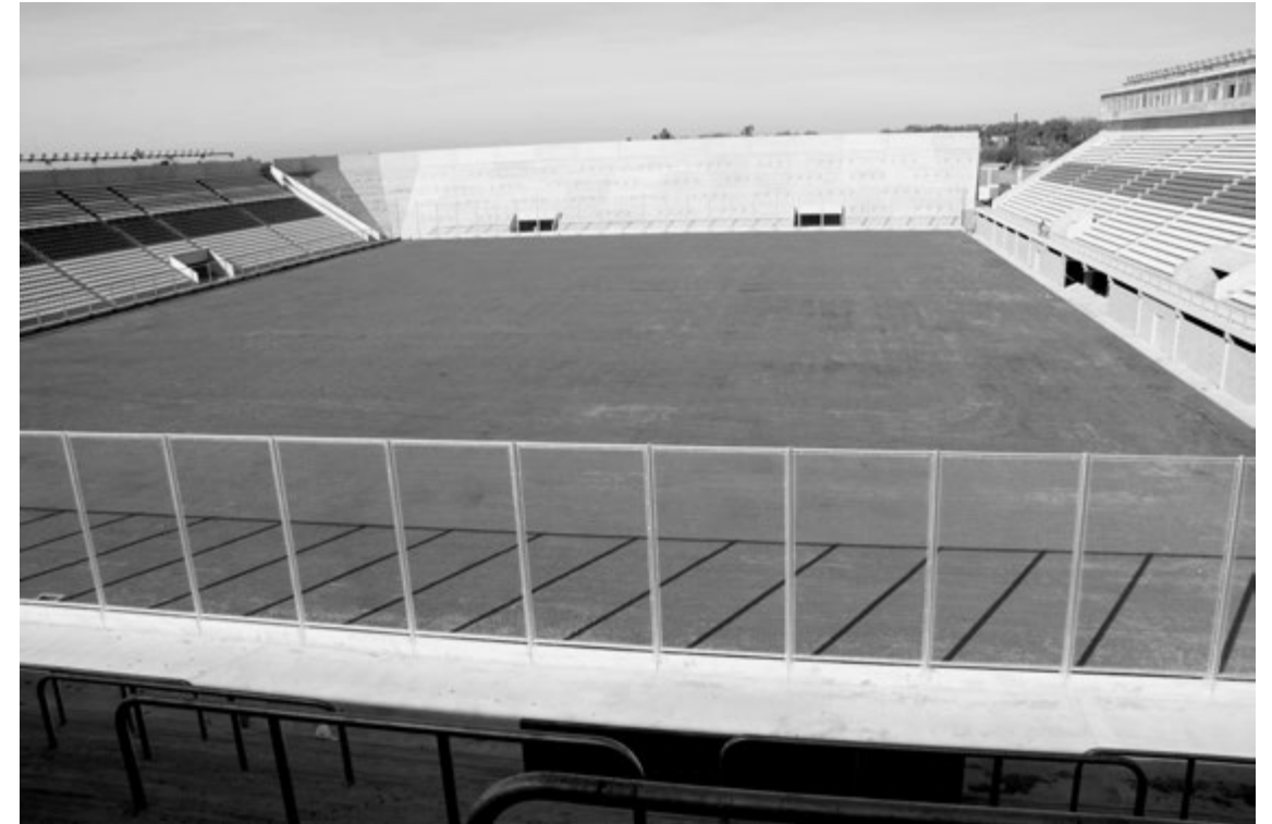
Obra finalizada del Estadio "Nuevo Francisco Urbano"
