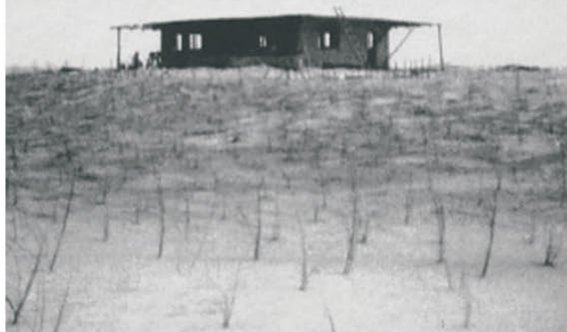
La "casa de las cuatro puertas" en construcción, diciembre de 1931. Fue la primera vivienda familiar de don Carlos Gesell sobre las dunas. (Actualmente, Museo y Archivo Histórico Municipal de Villa Gesell)
