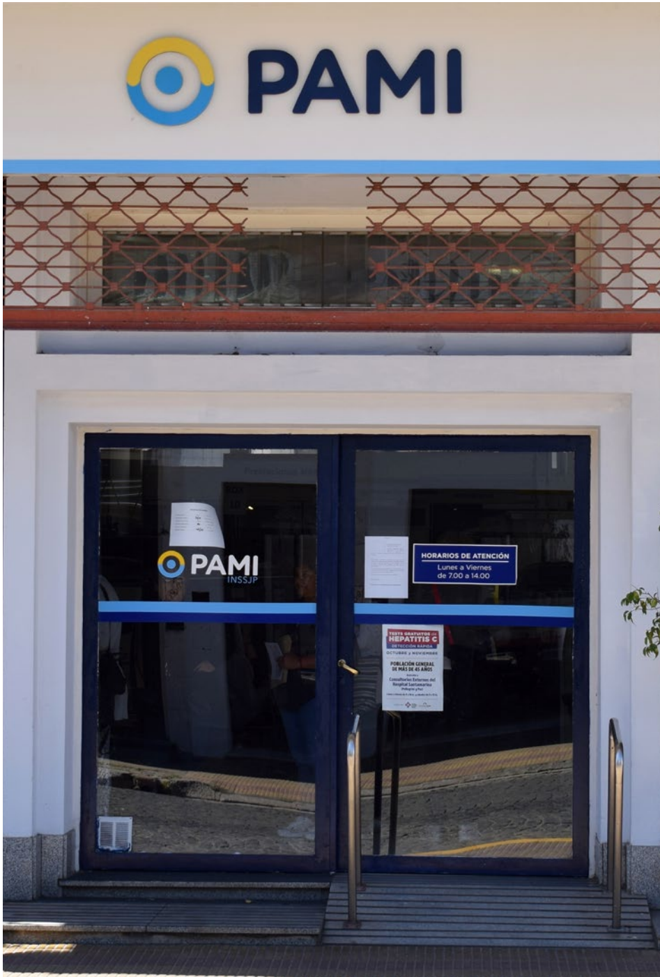
Figura nº 2. Oficinas del PAMI. Fuente: Archivo IGEHCS, CONICET/UNCPBA.
