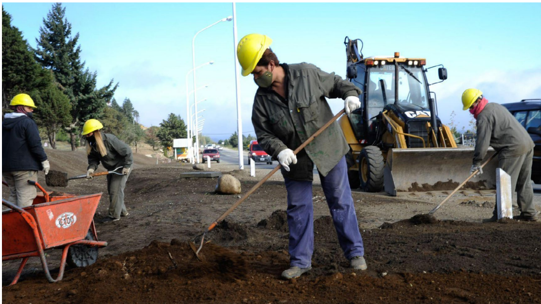
Mujeres construyendo. Fuente: banco de imágenes MOP.
