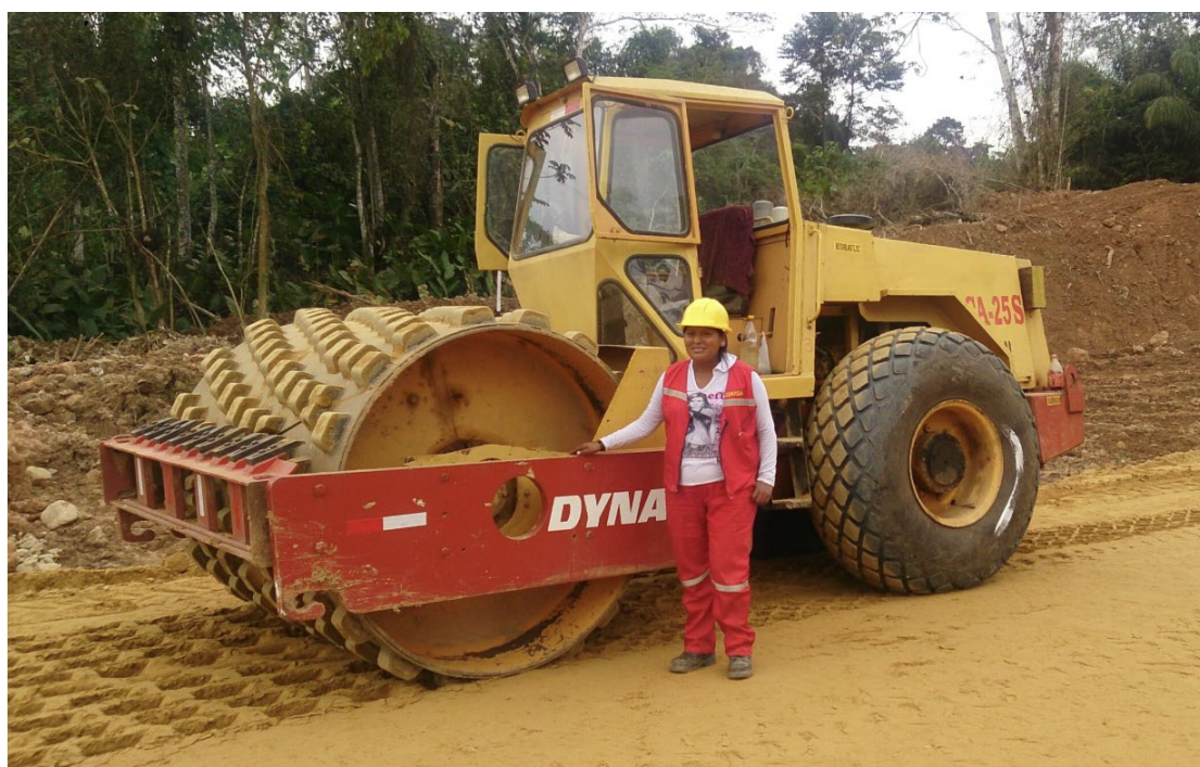
Imagen: operaria trabajando. fuente: BID 2020
