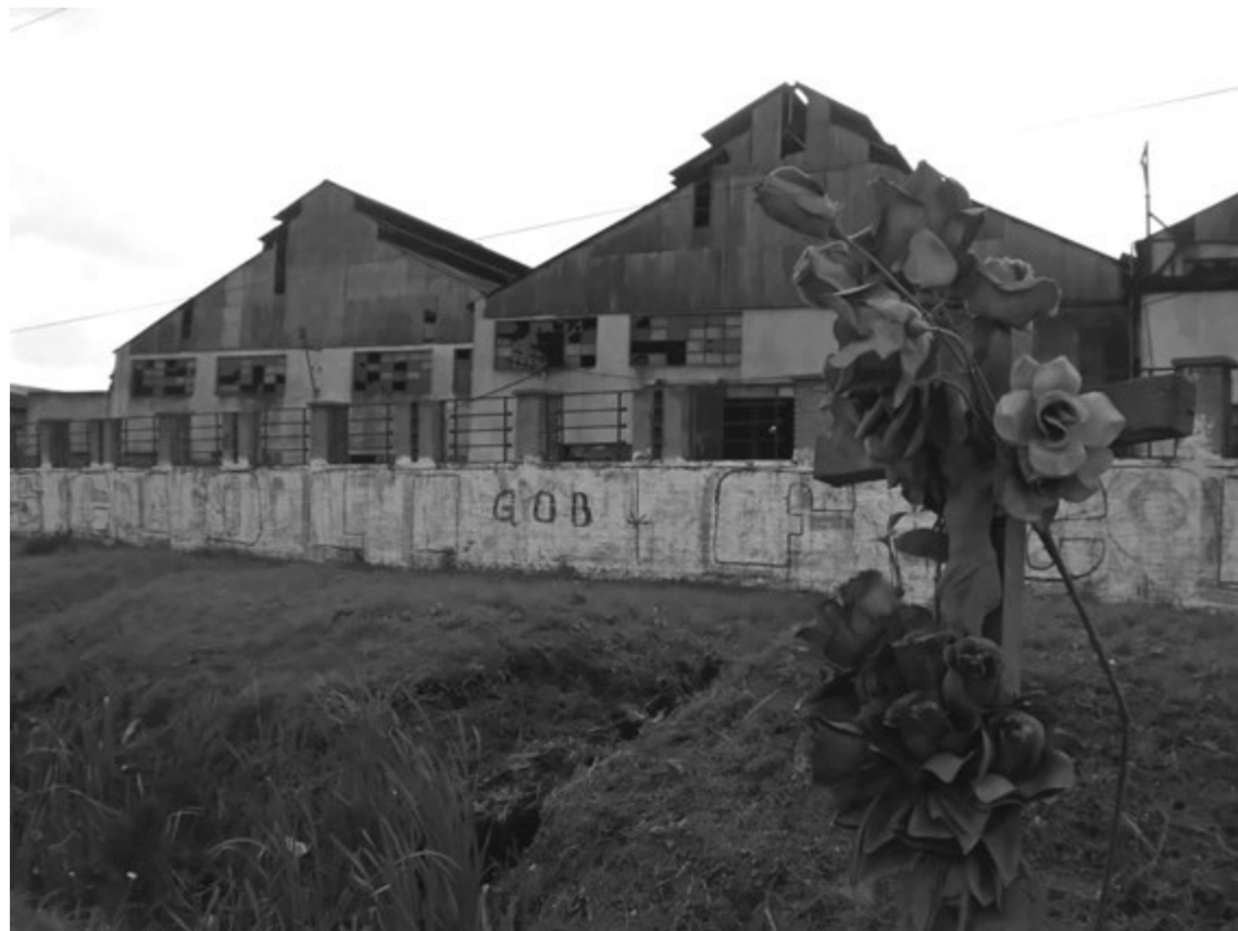
Ex fábrica La Baskonia, actualmente Cooperativa Fundición L.B. Foto del autor
