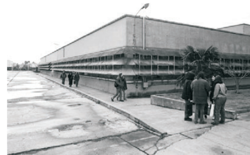
Sección sobre la calle Florencio Varela, primera en ser remodelada y sede del rectorado actual. Allí se realizó la inauguración de la UNLaM
